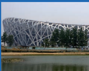
Stadio Olimpico "Nido d'uccello", Pechino - Cina: Realizzazione dell'impermeabilizzazione di 25.000 m² di gradinate, parcheggi e terrazze ambientali (2008).
