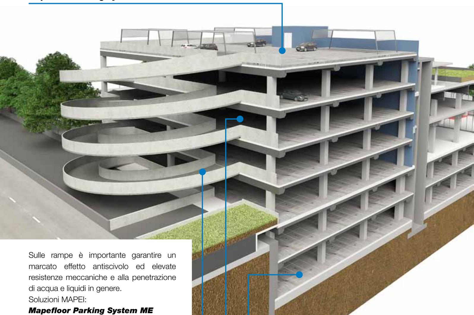
Sulle rampe è importante garantire un marcato effetto antiscivolo ed elevate resistenze meccaniche e alla penetrazione di acqua e liquidi in genere.
