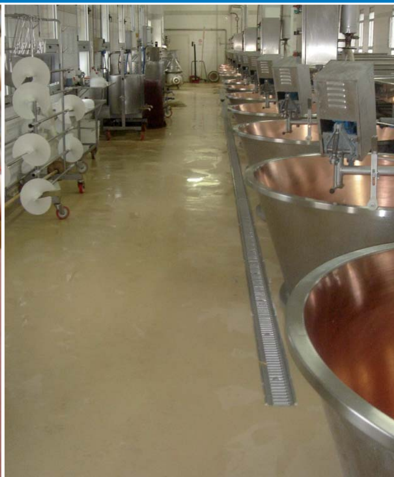
Latteria Sociale Minozzo - Minozzo (RE) Prodotti impiegati: MAPEFLOOR CPU/HD MAPEFLEX PU45
