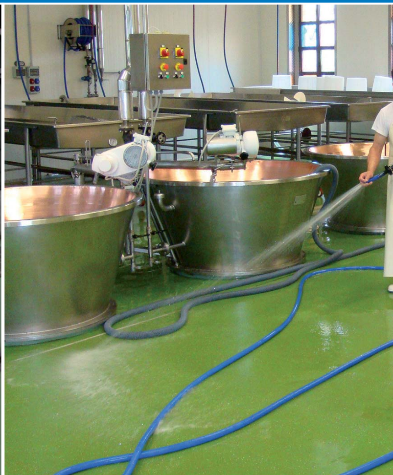
Latteria Salvaterra - Salvaterra (RE) Prodotti impiegati: MAPEFLOOR CPU/HD
