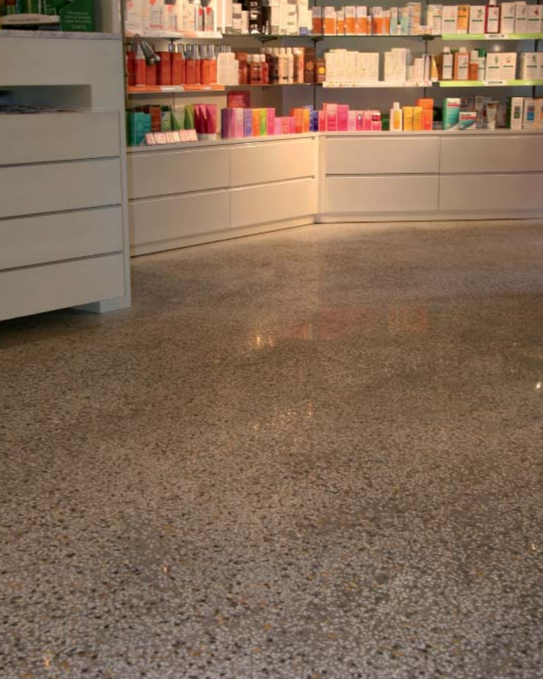
Farmacia - Pistoia (PT) - Italia Prodotti usati: ULTRATOP SYSTEM “effetto terrazzo alla veneziana”
