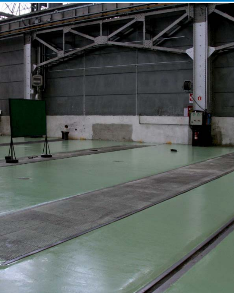
Magazzini OGR - Foligno (PG) - Italia Prodotti usati: MAPEFLOOR SYSTEM 31 MAPEFLOOR SYSTEM 91
