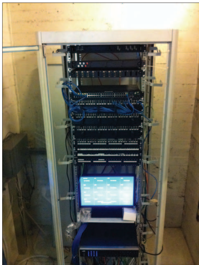
Posa cavi in fibre ottiche e cavi utp per cablaggio strutturato per il nuovo capanone. Armadio generale dati e controllo video-camere
