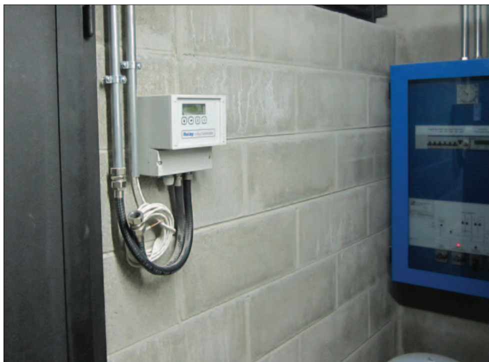
Sotto: dettaglio controllo bus contabilizzatori appartamenti
