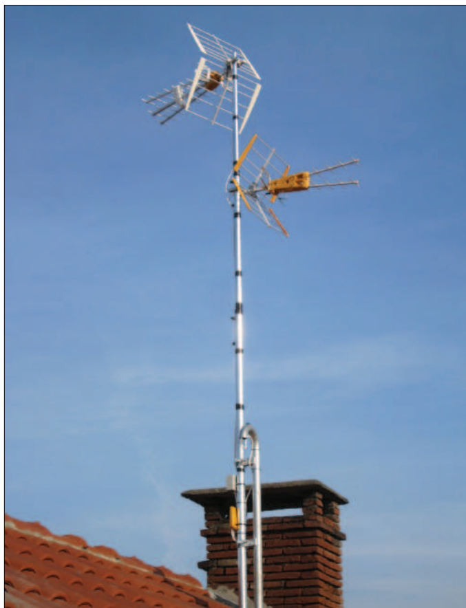
Sopra: antenna terrestre dopo il montaggio
