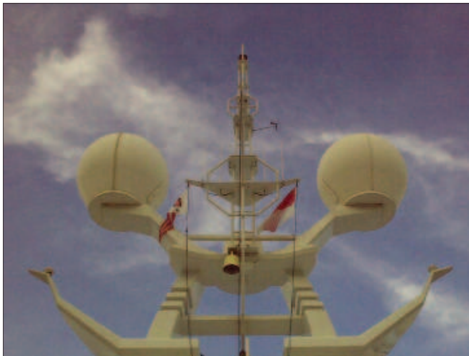
Sostituzione cavi antenne radio e tv satellitare
