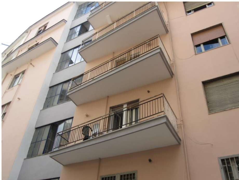
Ristrutturazione Fabbricato Via P.Castellino, Napoli
