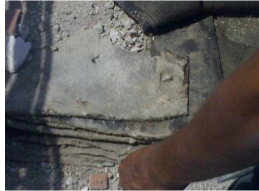
Rimozione di guaina bituminosa
