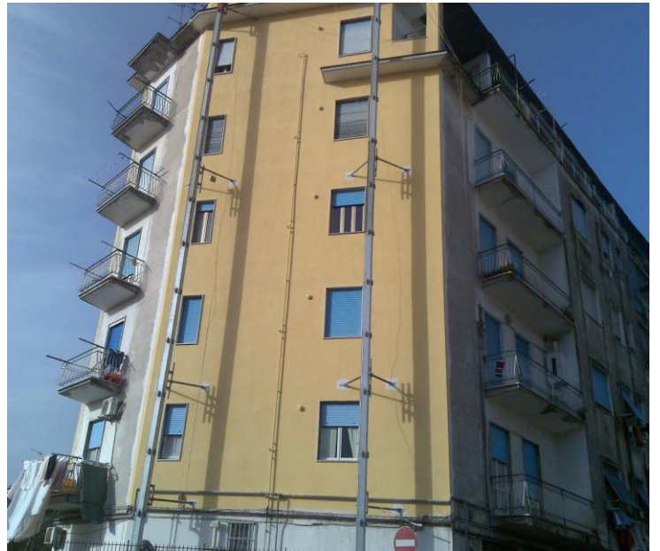
Ristrutturazione fabbricato Secondigliano
