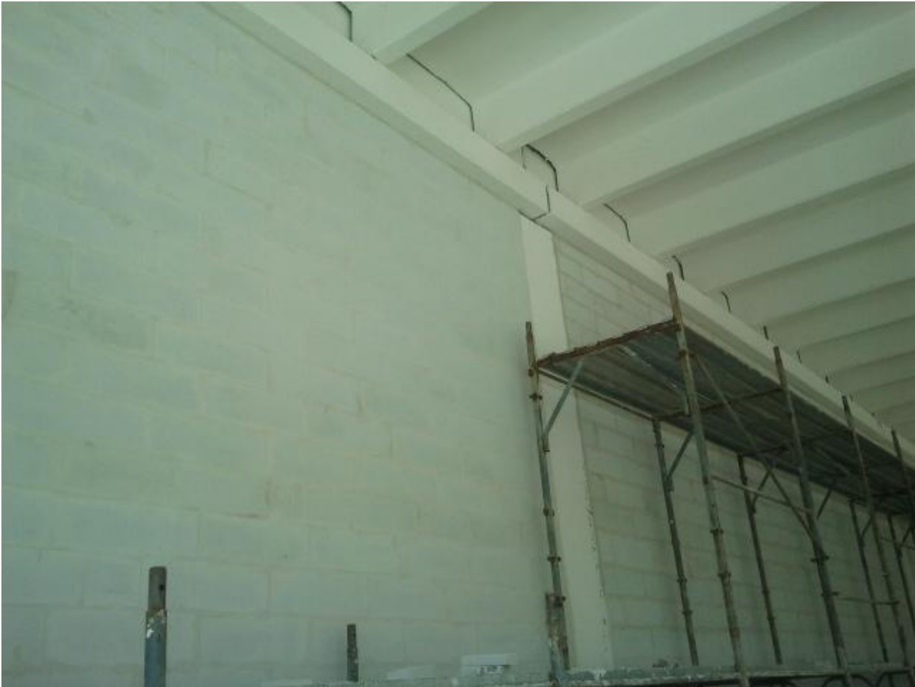
Vista interna murature
