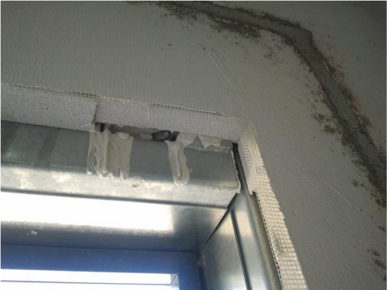
Particolare della rasatura armata.
