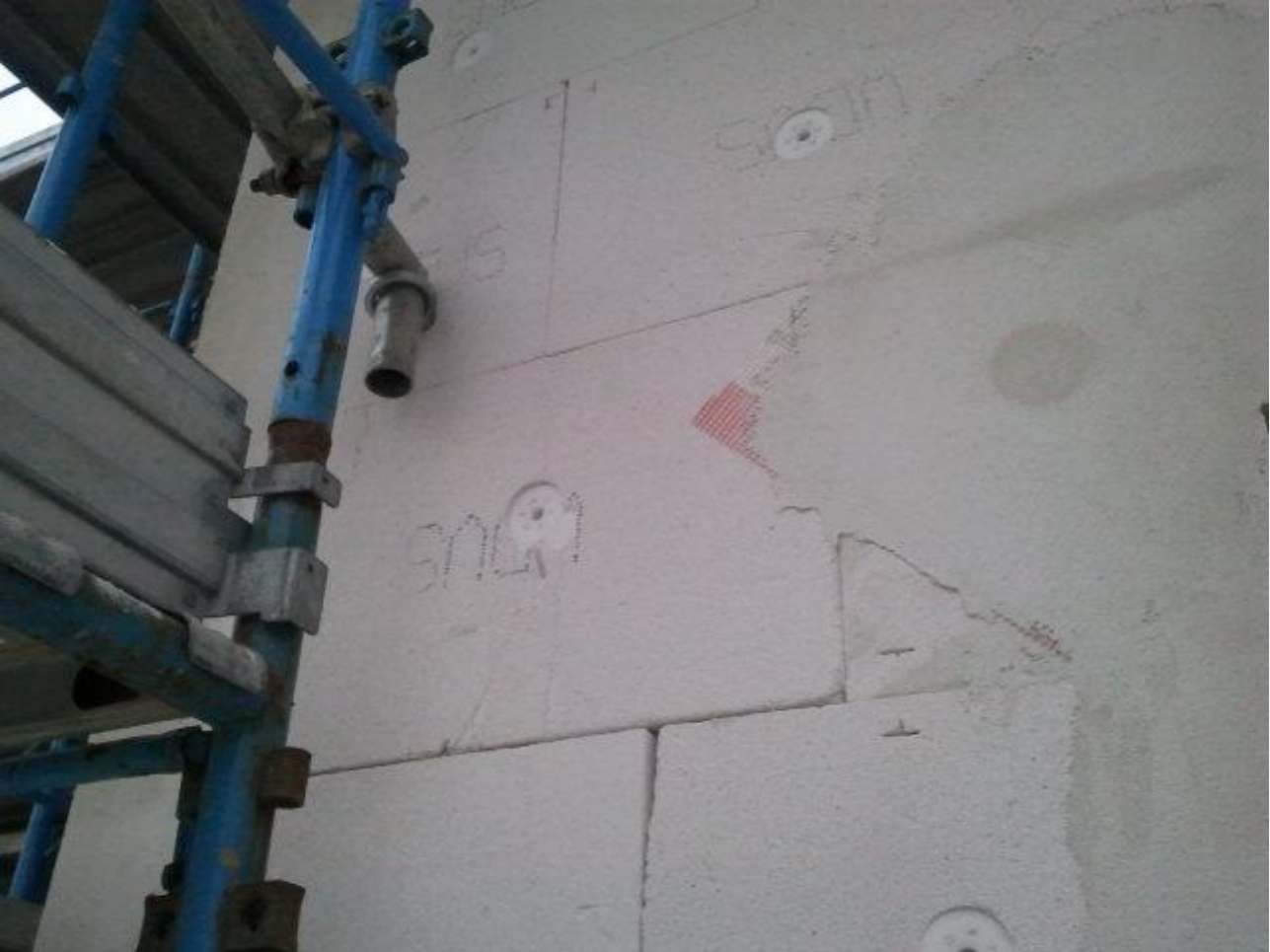
Particolare rete a 45 gradi e tasselli STRU Ejot (cert.ETAG).
