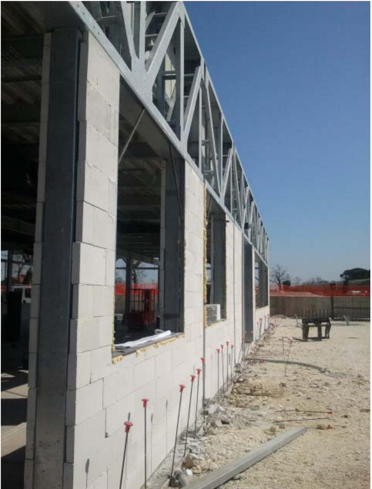
PARTICOLARE SAGOMATURA BLOCCO SU PILASTRO IN ACCIAIO.
