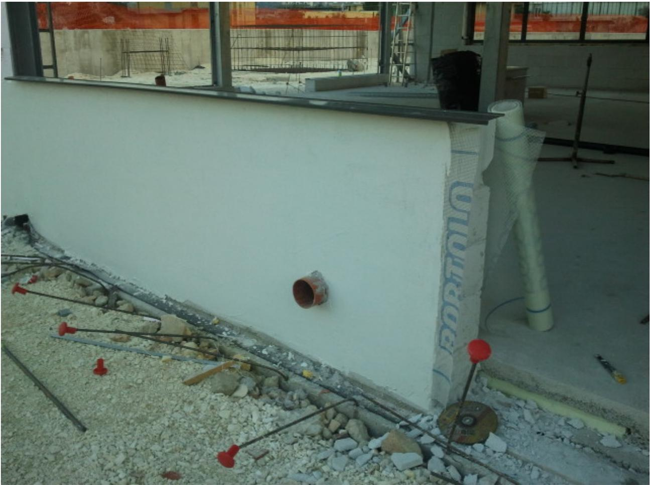
MURATURA DI COMPARTIMENTAZIONE REI COMPOSTA DA BLOCCHI DA CM. 30 CON CREAZIONE DI PILASTRINI E TRAVI ROMPITRATTA OGNI SPECCHIATURA DI MT. 4X4
