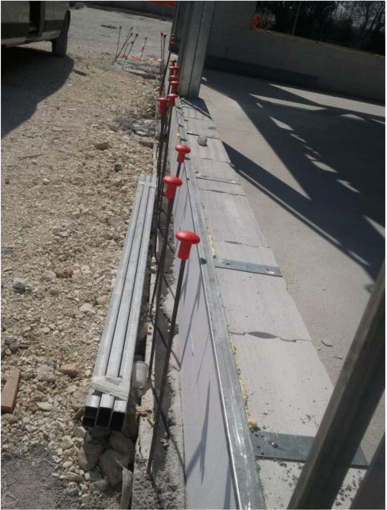
SISTEMA DI ANCORAGGIO DEL TELAIO DEGLI INFISSI.
