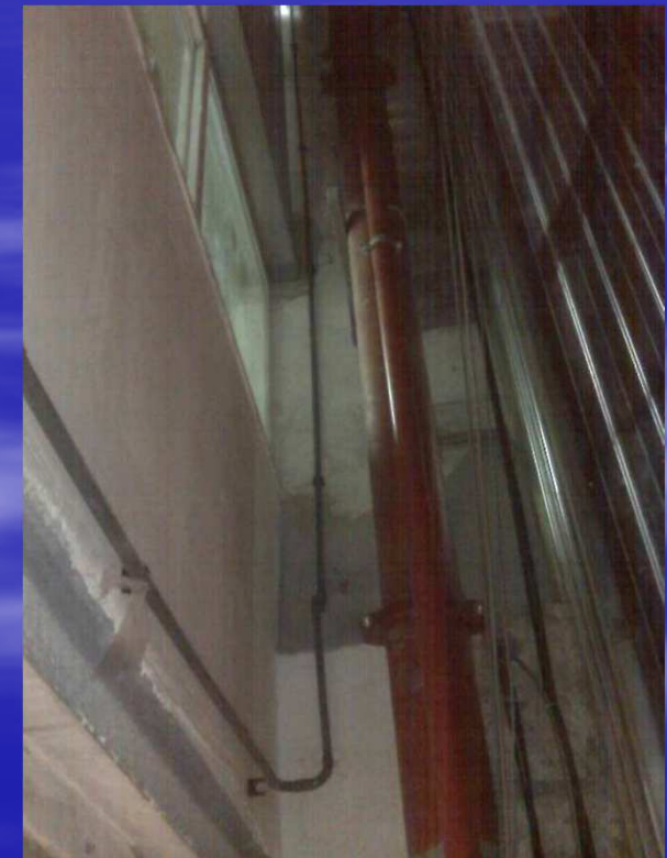
Salita tubo vano tecnico
