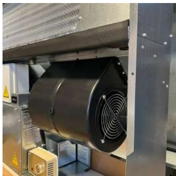
Ventilatore centrifugo
